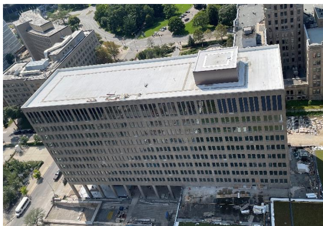
Photo : Achèvement de l'installation de fenêtres « perforées ».
