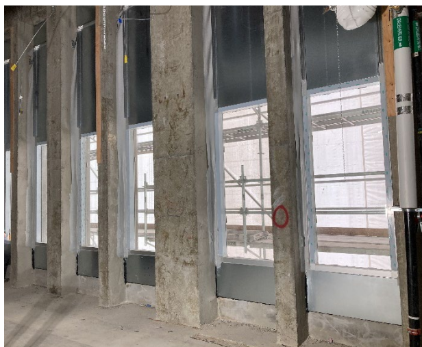
Photo : Fenêtres en cours de réinstallation dans la Tour Hepburn
