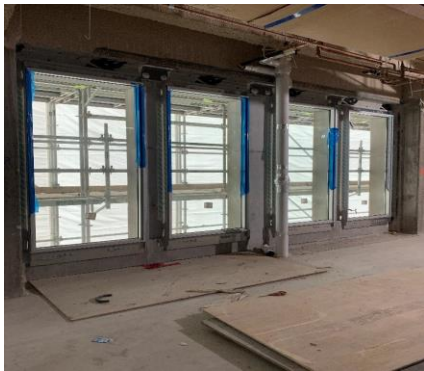
Photo : Nouvelles fenêtres à la tour Ferguson
