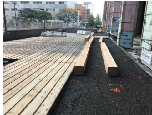
Photo : Des nattes pour terrains boueux protègent les éléments du patrimoine sous l'échafaudage.
